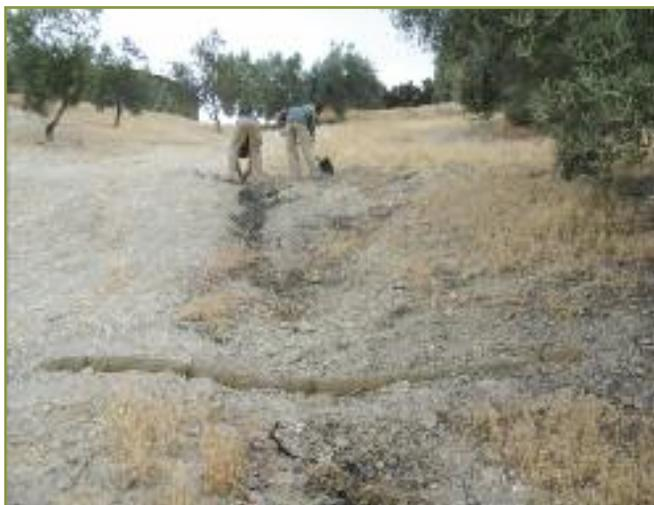
**Fotografía 7. Modelo 1 a base de biorrollos de 15 cm de diámetro sobre regueros de menos de 15 cm.**
