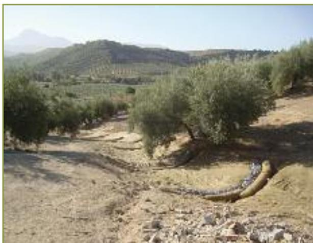
**Fotografía 9. Modelo 3 a base relleno de cárcavas de 1 m y cobertura con mantas, biorrollos y gaviones flexibles.**
