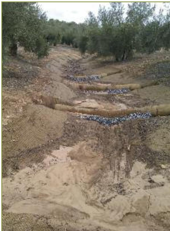
**Fotografía 27. Seguimiento de los filtros para comprobar su adherencia tras las primeras lluvias.**
