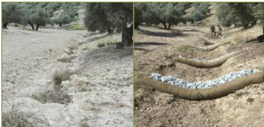
**Fotografía 8. Antes y después del modelo 2 a base de biorrollos de 30 sobre gaviones flexibles en cárcavas de más de 50 cm.**
