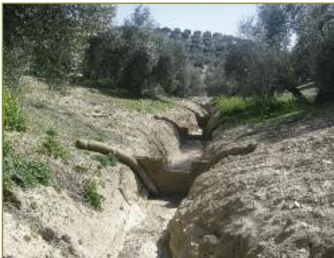
**Fotografía 10. Modelo 4 a base de empalizadas de acero con cerramientos de mantas y biorrollos sobre cárcavas de más de 1,5 m.**
