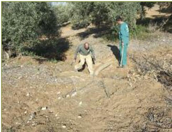
**Fotografía 14. Instalación de biorrollos de 15 cm (modelo 1) en zanjas de atado: importancia del mantenimiento de la capacidad central de desagüe.**
