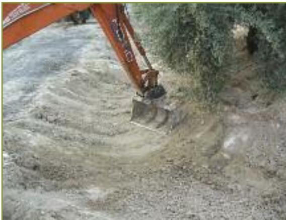
Fotografía 16. Relleno y perfilado de cárcavas en modelo 3.
