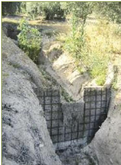
Fotografía 20. Empalizada metálica del modelo 4 integrada en la cárcava.
