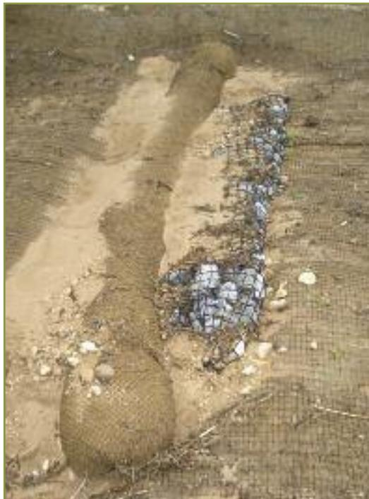
**Fotografía 15.- Retención de sedimentos en la estructura biorrollo/gavión en el curso de agua.**
