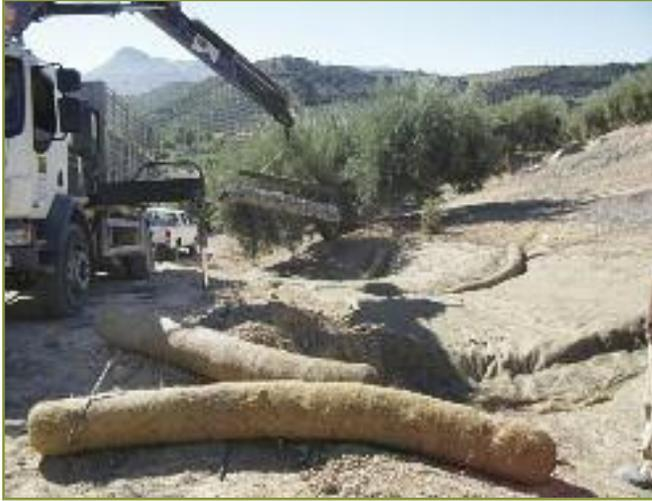
**Fotografía 18. Instalación de mantas orgánicas, biorrollos y gaviones flexibles en zanjas excavadas sobre el relleno de las cárcavas (modelo 3).**
